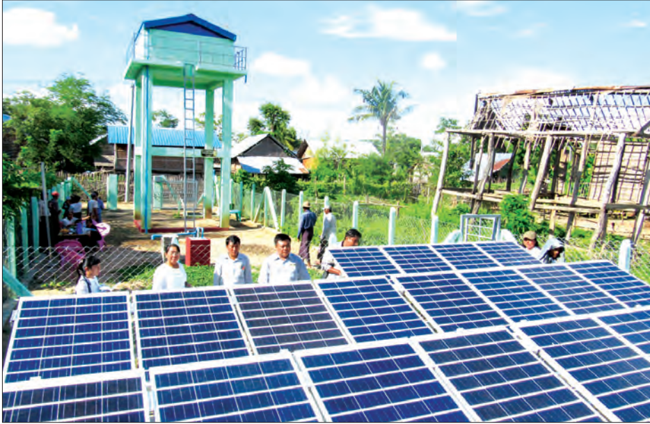
ပွင့်ဖြူမြို့နယ် နဘဲကုန်းကျေးရွာ၌ နေစွမ်းအင်ဖြင့် အိမ်တိုင်ရာရောက် ရေပေးရေးစနစ် ဆောင်ရွက်ပြီးစီးနေမှုကို တွေ့ရစဉ်။
