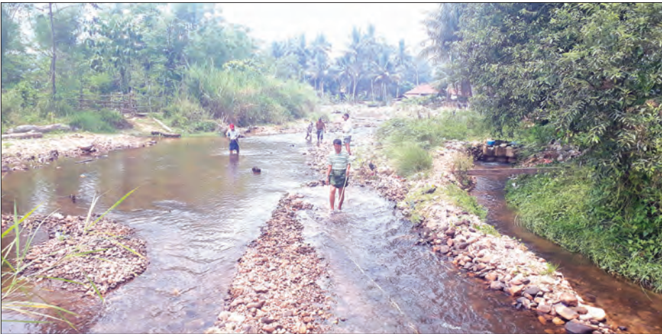
ကြမ်းပြင်တူးဖော်ခြင်းဆောင်ရွက်မည့် နမ့်ဖောင်ချောင်းတစ်နေရာ။
