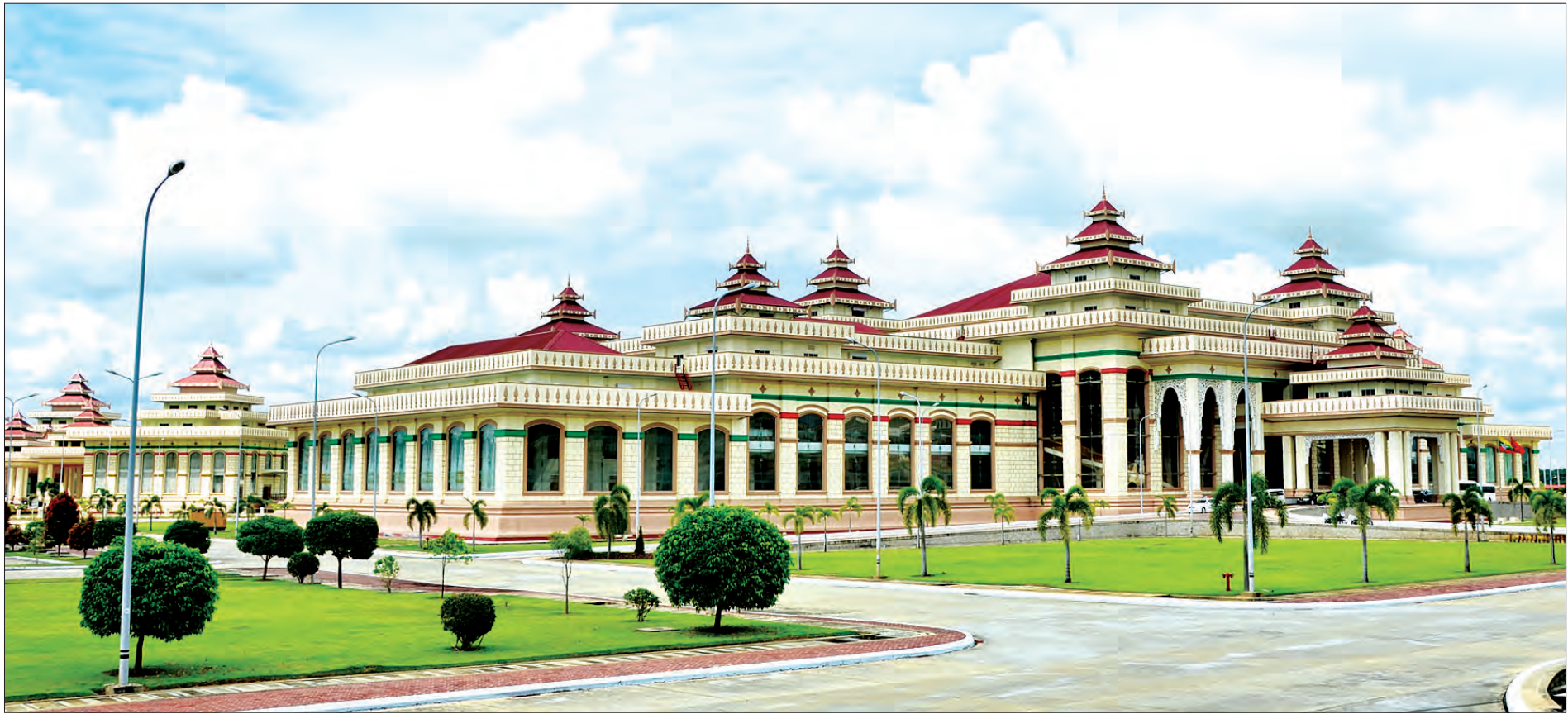
အမျိုးသားလွှတ်တော်အဆောက်အအုံကို တွေ့ရစဉ်။
