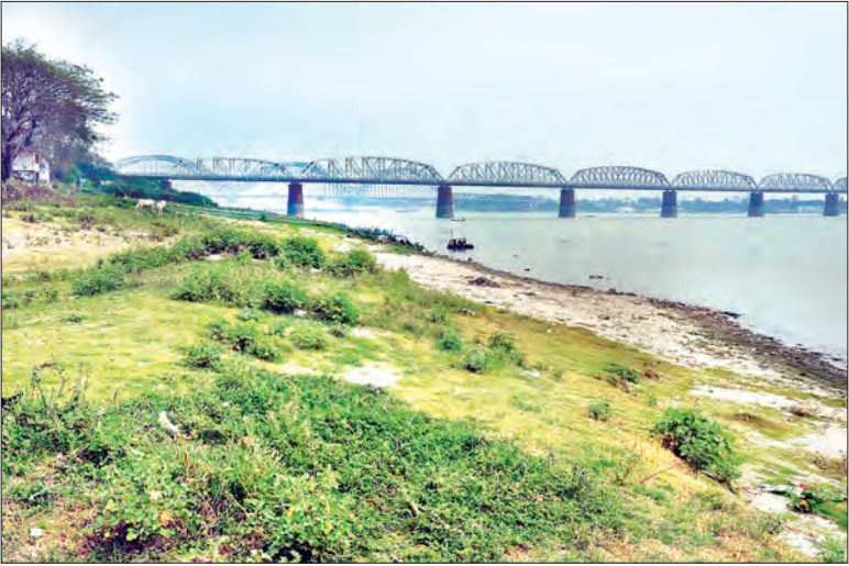
ဟိုတယ်ငုန်စီမံကိန်း အကောင်အထည်ဖော်မည့်နေရာမှ စစ်ကိုင်းတံတားကို လှမ်းမြင်ရစဉ်။
