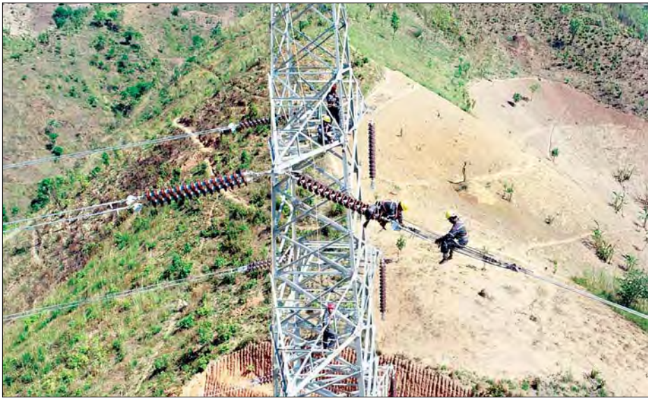
နမ့်စန် - မိုင်းပျဉ်း - ကျိုင်းတုံ ဓာတ်အားလိုင်းကြိုးဆွဲလုပ်ငန်းများ ဆောင်ရွက်နေစဉ်။
