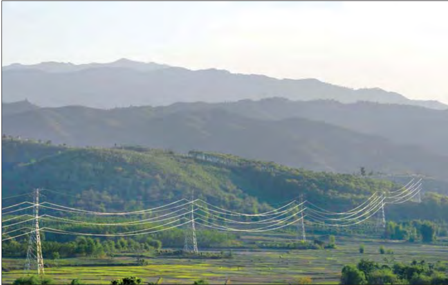
နမ့်စန် - မိုင်းပျဉ်း - ကျိုင်းတုံ ဓာတ်အားလိုင်းကြိုးဆွဲလုပ်ငန်းများ ဆောင်ရွက်ပြီးစီးမှုကို တွေ့ရစဉ်။
