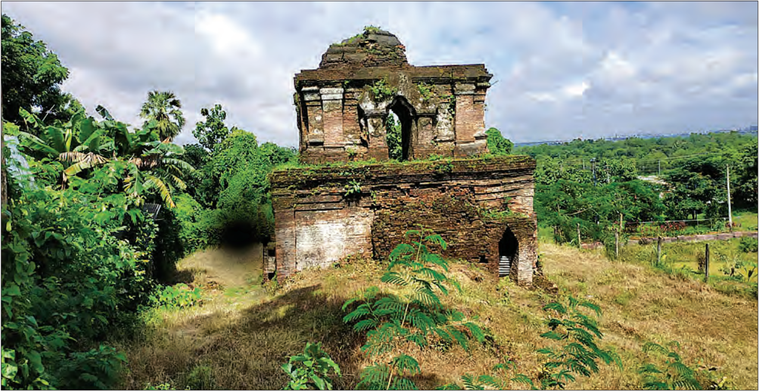
နတ်ရှင်နောင်၏ အရိုးအုတ်ဂူကို တွေ့ရစဉ်။
