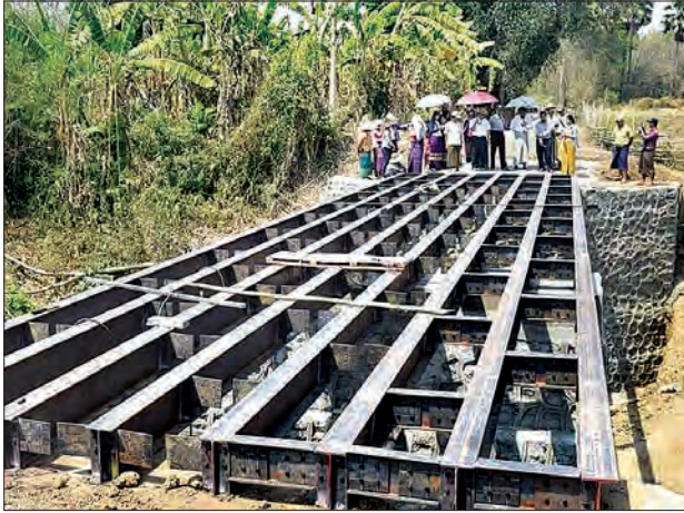
ကျေးရွာအဝင်တံတား တည်ဆောက်နေမှု တာဝန်ရှိသူများ ကွင်းဆင်းစစ်ဆေးစဉ်။
