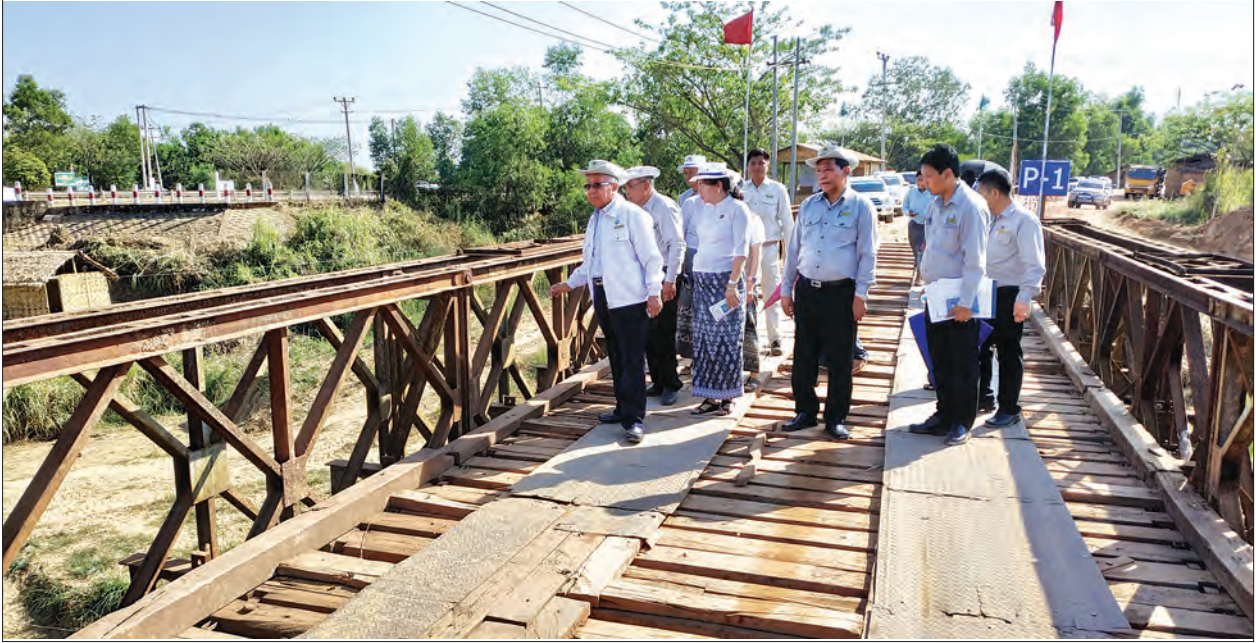
ပြည်ထောင်စုဝန်ကြီး ဦးဟန်ဇော် ငမိုးရိပ်ချောင်းကို ဖြတ်ကျော်တည်ဆောက်ထားသည့် ဘေလီတံတားဟောင်းကြံ့ခိုင်မှုကို ကြည့်ရှုစစ်ဆေးစဉ်။
