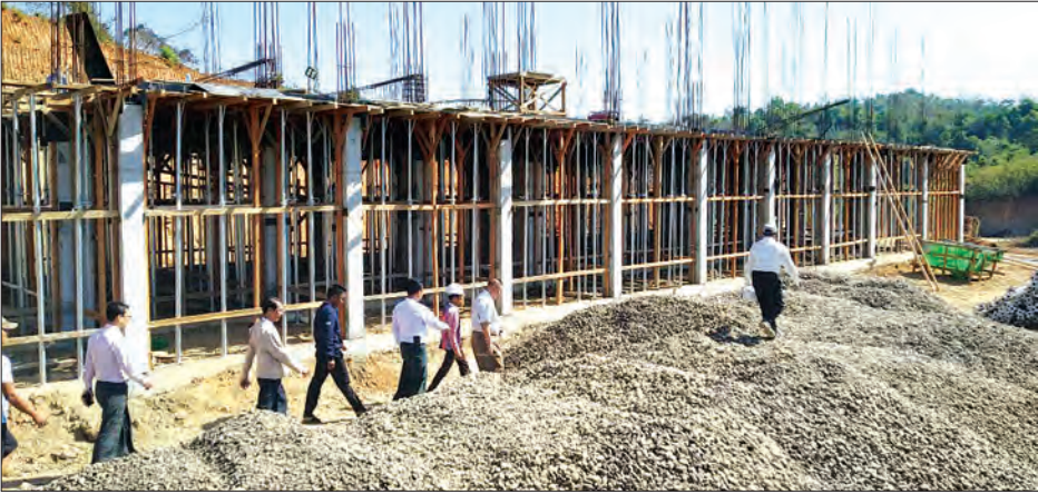
ဂွမြို့ နည်းပညာအထက်တန်းကျောင်း တည်ဆောက်ရေးလုပ်ငန်းခွင်ကို တွေ့ရစဉ်။
