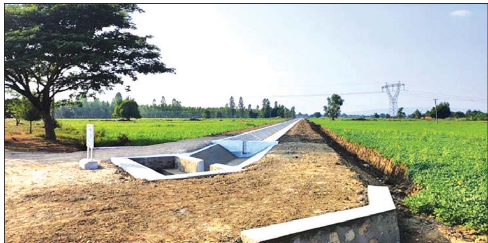
ရေဆင်းဆည် လက်ယာ(၁)မြောင်းမကြီး မိုင်နာ(၇)မြောင်းအဆုံးရှိ Tail Structure အား ပြန်လည်ပြုပြင်ပြီးစီးမှုကို တွေ့ရစဉ်။
