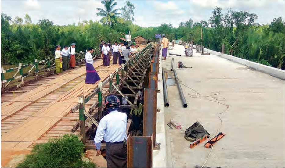
အသစ်တည်ဆောက်လျက်ရှိသော မြို့ဟောင်းချောင်း ကွန်ကရစ်တံတားတည်ဆောက်မှု လုပ်ငန်းခွင်ကို တွေ့ရစဉ်။
