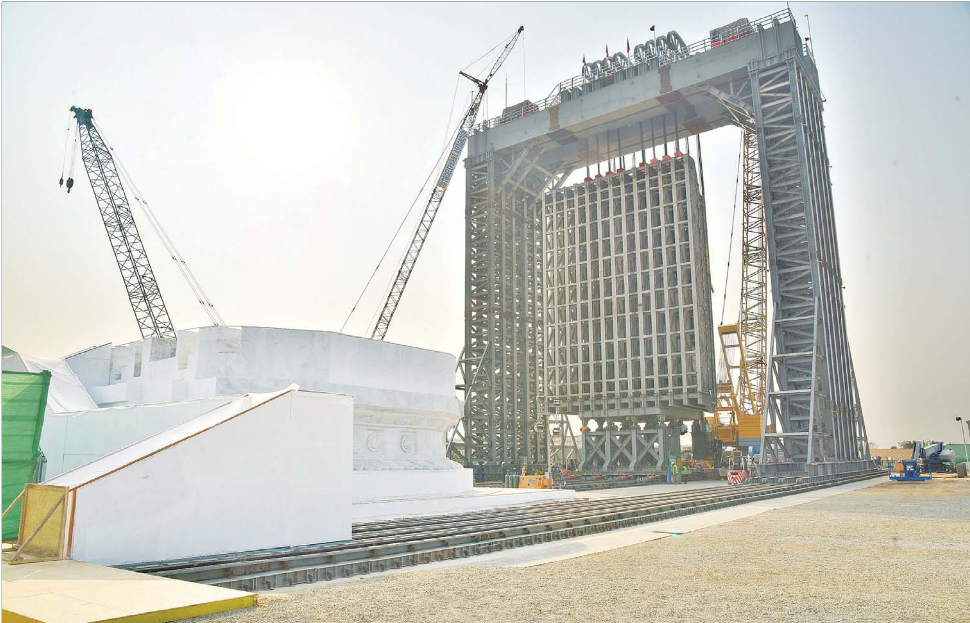
မာရဝိယေဗုဒ္ဓရုပ်ပွားတော်မြတ်ကြီးအား သံမဏိမျှော်စင် ဝန်ချိစက် အသုံးပြု၍ ရတနာပလ္လင်တော်ထက်သို့ ပင့်ထောင်ပူဇော်လျက်ရှိရာ ဇန်နဝါရီ ၂၉ ရက် နံနက် ၉ နာရီတွင် ၉၀ ဒီဂရီအထိ ပင့်ထောင်ပူဇော်ပြီးစီးမှုကို ဖူးတွေ့ရစဉ်။
