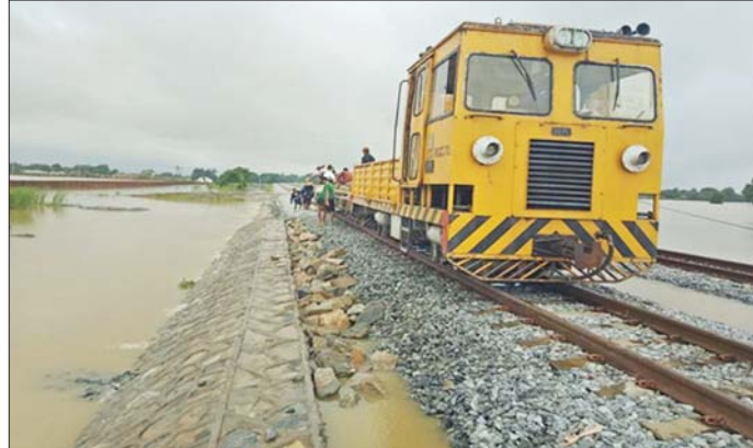
ရန်ကုန်-မန္တလေးရထားလမ်းပိုင်း၊ ပဲခူး-ရွှေလှေအကြား ရထားလမ်းတာပေါင် ရေတိုက်စားထားသော နေရာများအား ကျောက်ကြီးများ ချယူစီထည့်ပြုပြင်နေမှုကို တွေ့ရစဉ်။
