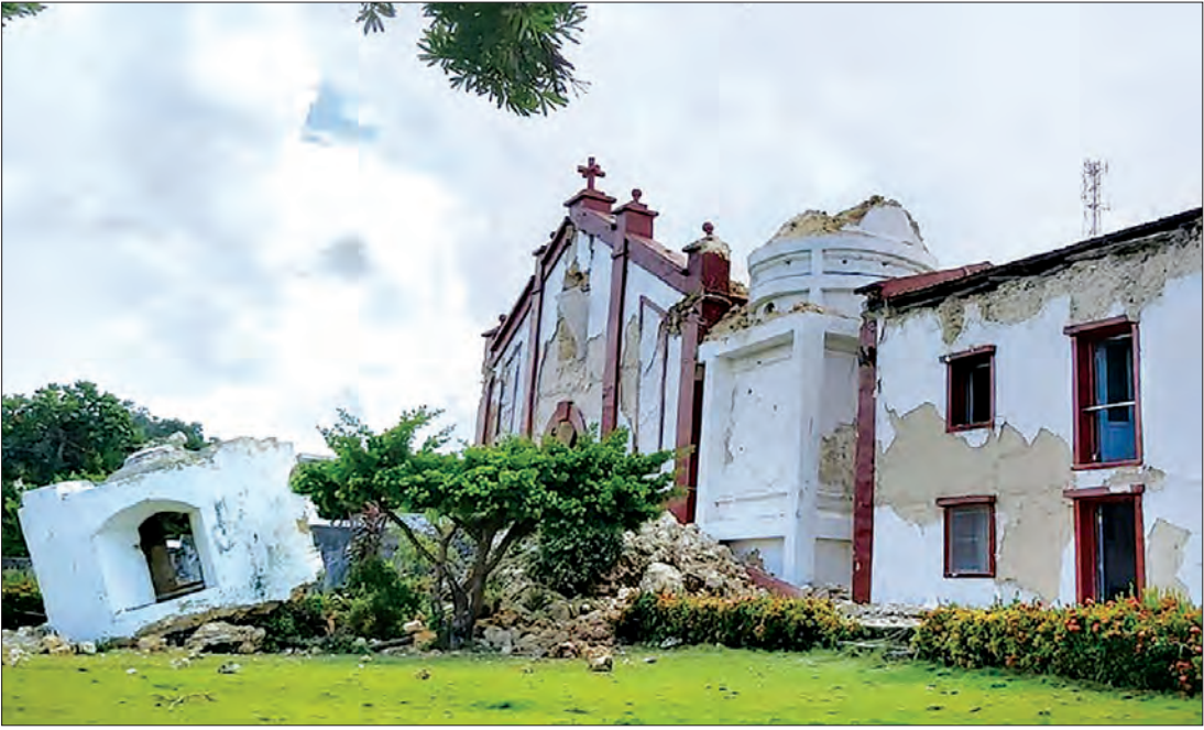
ငလျင်လှုပ်ခတ်မှုကြောင့် အဆောက်အအုံတစ်လုံး ပြိုကျပျက်စီးမှုကို တွေ့ရစဉ်။
