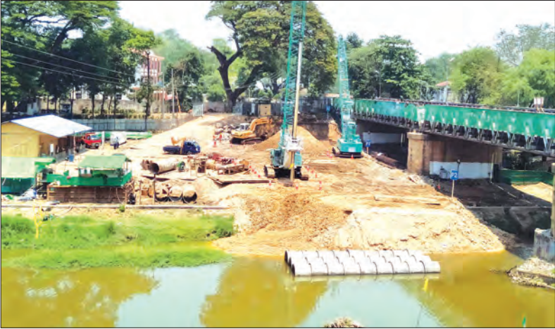
ငလိုက်ချောင်းကူးတံတားသစ်ကြီး ဆောက်လုပ်နေသည့်လုပ်ငန်းခွင်ကို တွေ့ရစဉ်။
