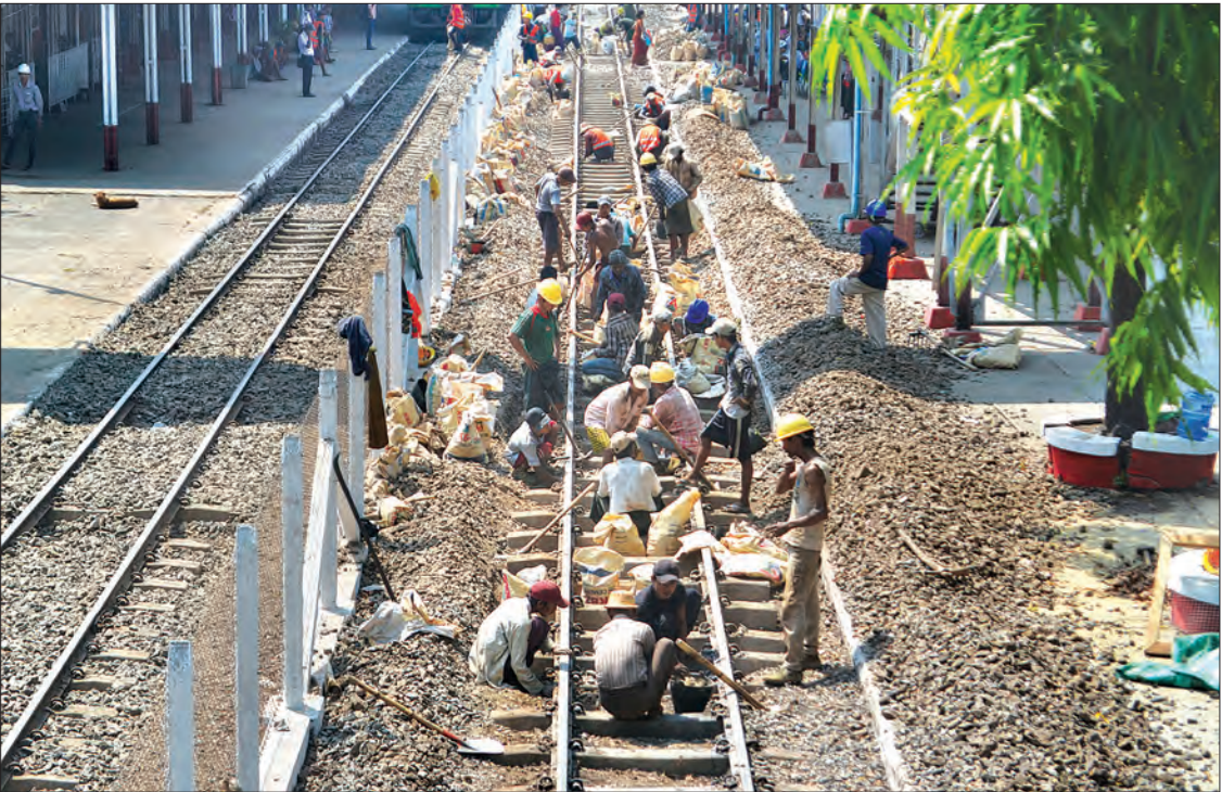
အင်းစိန်ဘူတာ၌ ရထားလမ်းပိုင်းအဆင့်မြင့်တင်ရေးဆောင်ရွက်နေမှုကို တွေ့ရစဉ်။
