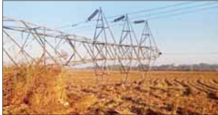
အကြမ်းဖက်သမားများ ပျက်ဆီးမှုကြောင့် ပြိုလဲပျက်စီးခဲ့သည့် ၁၃၂ ကေစီ ဘီလူးချောင်း (၂) - တီကျစ် နှစ်ထပ်ဓာတ်အားလိုင်း တာဝန်ရှိသူ အမှတ်(၁၁၅)။
