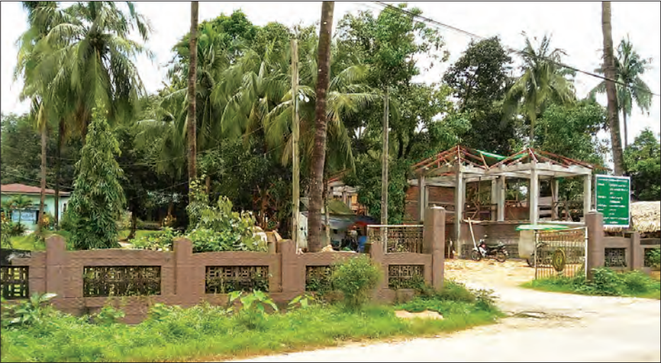
သိမ်ဆိပ်တိုက်နယ်ဆေးရုံ၌ ဝန်ထမ်းအိမ်ရာတည်ဆောက်နေမှုကို တွေ့ရစဉ်။
