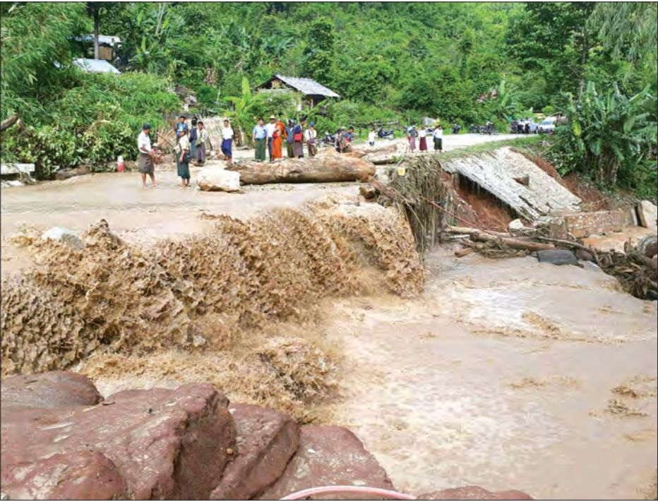
စက်ယန္တရားများဖြင့် ဖယ်ရှားတံတားထိပ်ဝတွင် ပိတ်ဆို့နေသော သစ်တုံးများနှင့် အမှိုက်များအား ဖယ်ရှားရှင်းလင်း ဆောင်ရွက်လျက်ရှိဆက်လက်၍ စက်ယန္တရားများဖြင့် ကြောင်းသိရသည်။ တင်ဖိုးလွင်
