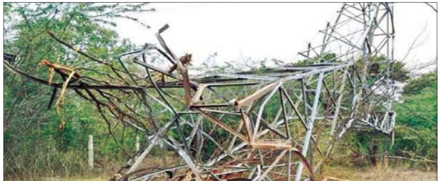
၁၃၂ ကေစီ ဪညောင်ပင်ကြီး - ဗုဒ္ဓကုန်းဓာတ်အားလိုင်း တာဝါတိုင်အမှတ် (၃၃၈) ဖောက်ခွဲဖျက်ဆီးခံရမှုကြောင့် ပြုလဲပျက်စီးမှုအား တွေ့ရစဉ်။
