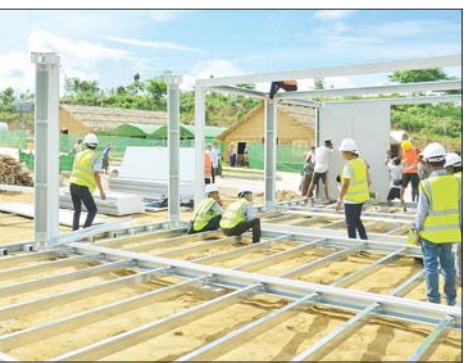
ပြုပြင်ခြင်း၊ Footing Block များ ခြင်းလုပ်ငန်းများကို ဆောင်ရွက် နိုင်ရေး စီမံဆောင်ရွက်လျက် ရောက်ရှိပြီး အမြန်တပ်ဆင်တည် ရှိကြောင်း သိရသည်။
