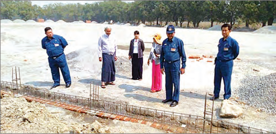
ပန်းဈေးဆိုင်ခန်းများ တည်ဆောက်ရန် အုတ်မြစ်ချထားစဉ်။
