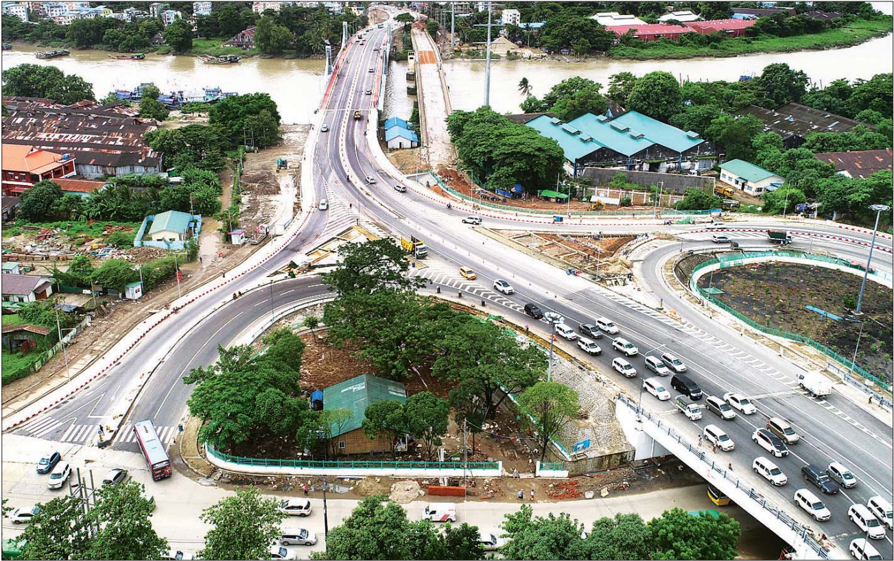
၂၇-၈-၂၀၁၈ ရက် ဇွန်လစ်ခဲ့သည့် ဂျပန်အင်ဂျင်နီယာများ အဆင့်မြင့်နည်းပညာများ အသုံးပြုကာတည်ဆောက်ခဲ့သော ရန်ကုန်တိုင်းဒေသကြီး ဒေါ်ပြုမြို့နယ်နှင့် မင်္ဂလာတောင်ညွန့်မြို့နယ်ကြားရှိ ပုဇွန်တောင်ချောင်းကူး ဒေါ်ပုတားသစ်ကို တွေ့ရစဉ်။
