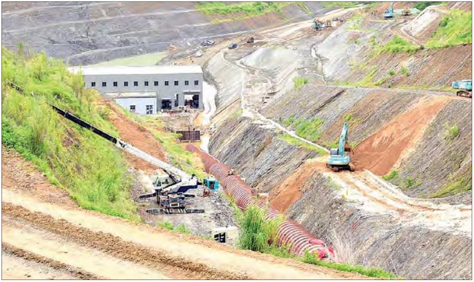
ကညင်ရေလှောင်တမံ ရေအားလျှပ်စစ်စီမံကိန်း အကောင်အထည်ဖော်ဆောင်ရွက်နေမှုကို တွေ့ရစဉ်။
