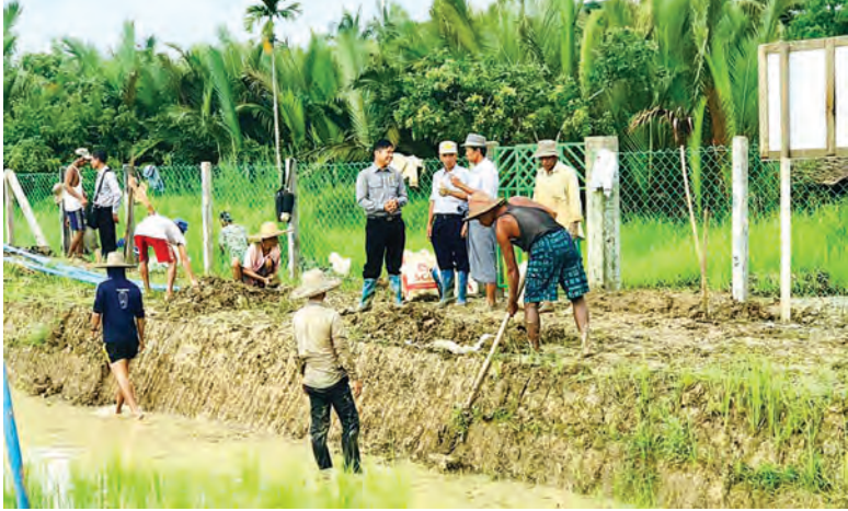
မွမ်းမံရန်ပုံငွေဖြင့် ရေကန်ဟောင်းပြန်လည်တူးဖော်ခြင်းဆောင်ရွက်ကြစဉ်။
