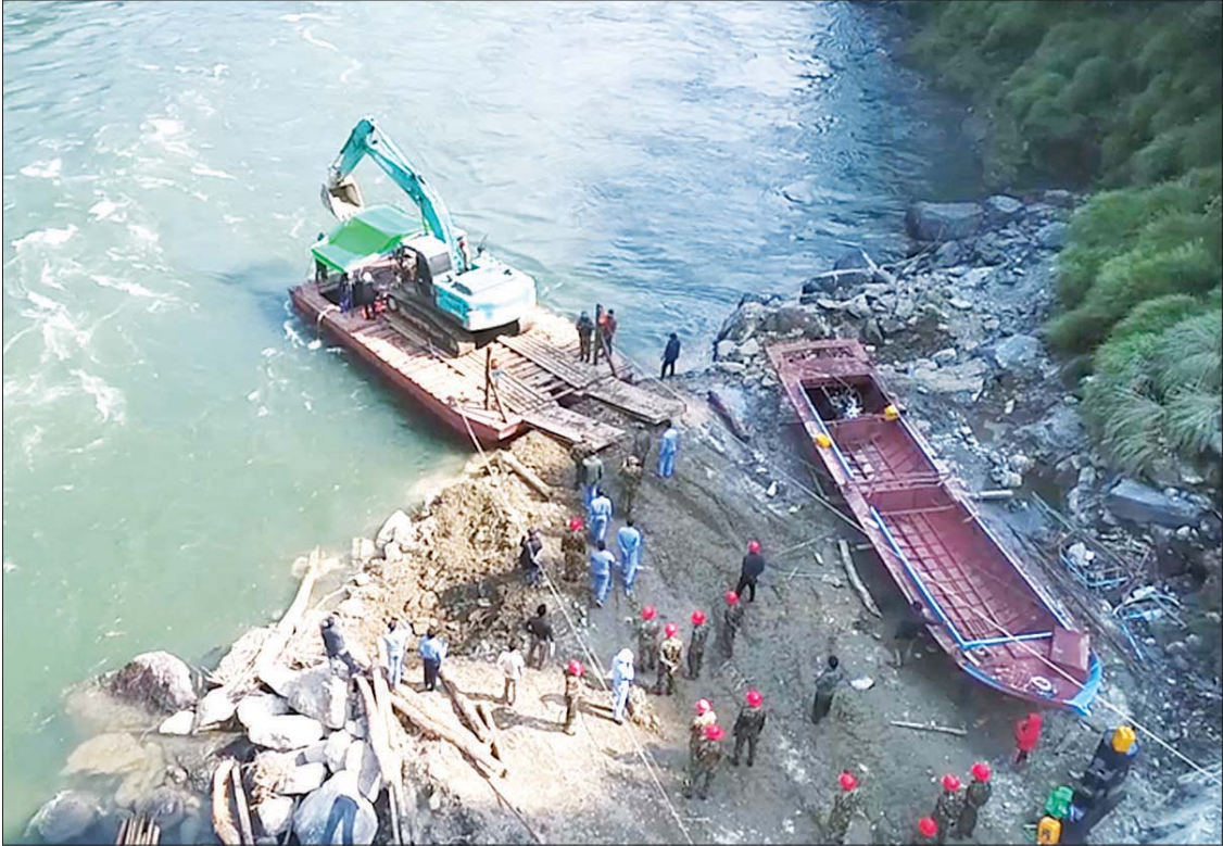
၁၄-၃-၂၀၂၀ ရက်က မဂ္ဂေဇ-ခေါင်လန်ဖူးလမ်း ဖောက်လုပ်ရေးတွင် အသုံးပြုမည့် ယန္တရားများ၊ စက်သုံးဆီများ၊ ယမ်းနှင့်ဆက်စပ်ပစ္စည်းများကို မေ့မြစ်တစ်ဖက်ကမ်းသို့ ယန္တရားကူးဖောင်ဖြင့် သယ်ဆောင်ဖြတ်ကူးရန် ပြင်ဆင်နေသည်ကို တွေ့ရစဉ်။
