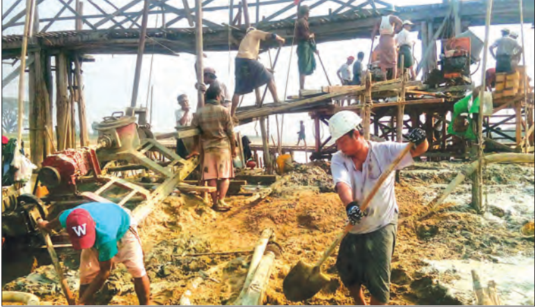
မဲဇာချောင်းကူးတံတား တည်ဆောက်နေသည့် လုပ်ငန်းခွင်ကို တွေ့ရစဉ်။
