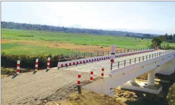
မင်းတုန်းမြို့နယ် ကြို့ကုန်း - ကလည်ကြားရှိ ကြို့ကုန်းကွန်ကရစ်တံတား။
