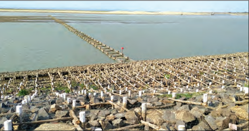
ကမ်းပြိုကာကွယ်ရေးဆောင်ရွက်ထားစဉ်
