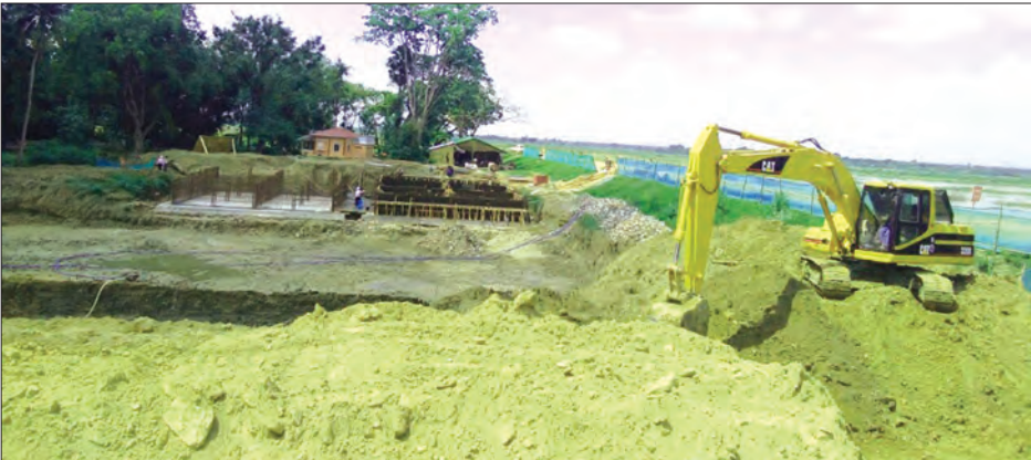
မိတ္ထီလာမြို့တွင် ရေပေးဝေနိုင်ရေးအတွက် ရေသန့်စင်စက်ရုံတည်ဆောက်နေစဉ်။
