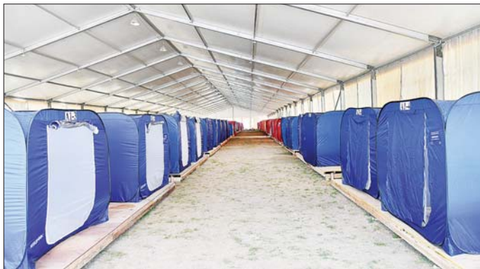
ဓနသိဒ္ဓိရပ်ကွက် ယာယီတည်းခိုရေးစခန်း အမှတ်(၁) တည်ဆောက်ထားမှုကို တွေ့ရစဉ်။
