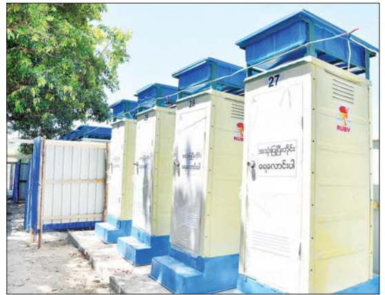
ရွေ့လျားအိမ်သာ (Mobile Toilet) များ တည်ဆောက်ထားရှိစဉ်။
