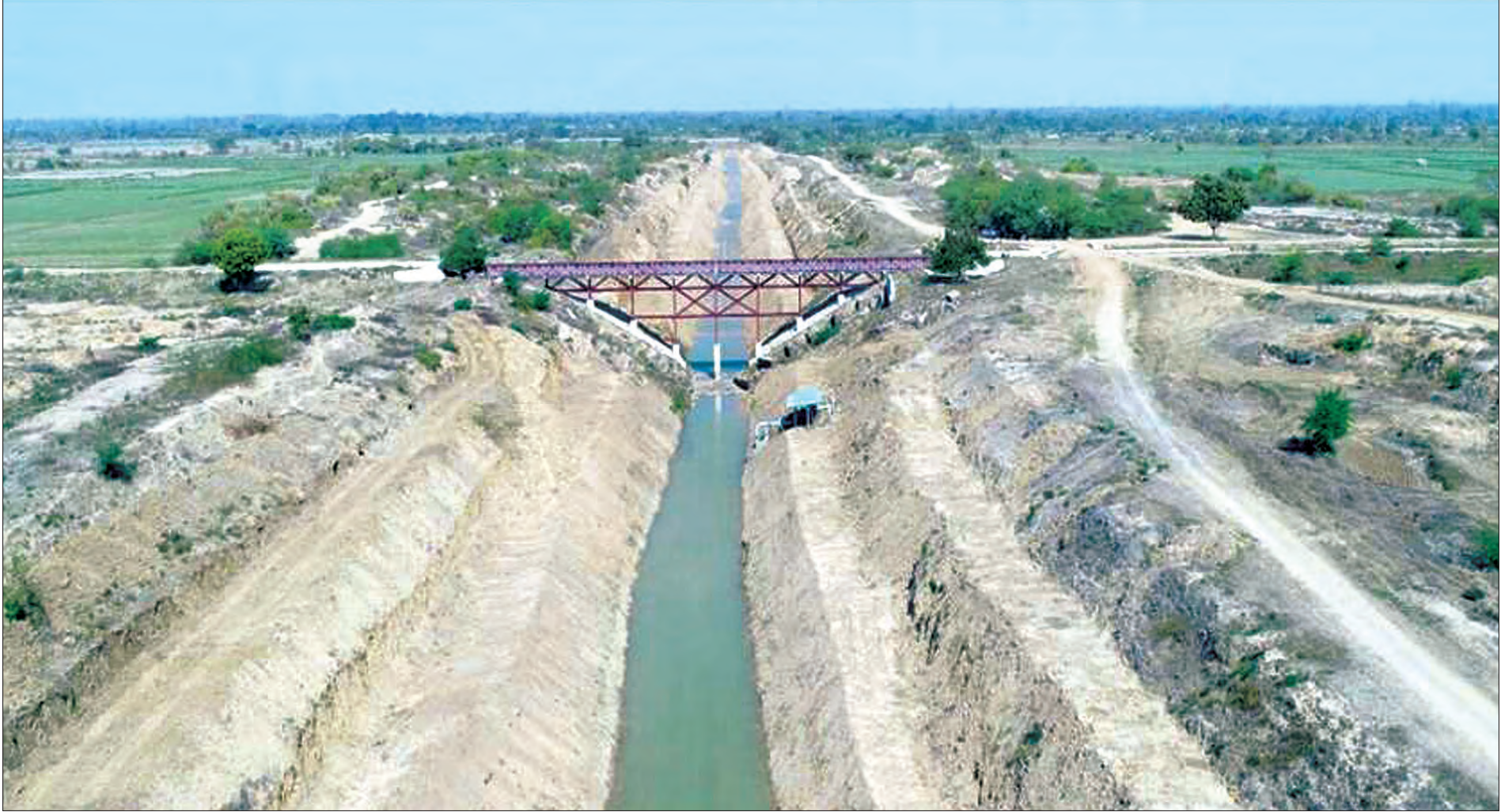
မကွေးတိုင်းဒေသကြီး စလင်းမြို့နယ် မကျီးပင်ပုကျေးရွာအနီးရှိ ဆင်ဖြူကျွန်းမြောင်း သဲနန်းတူးဖော်ခြင်းလုပ်ငန်းဆောင်ရွက်ထားမှုကို တွေ့ရစဉ်။
