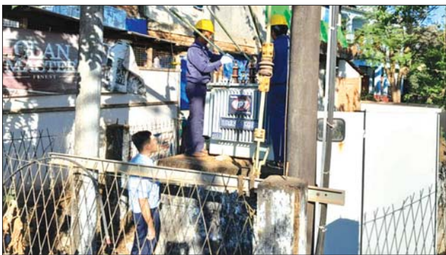
၀ ဒသမ ၄ ကေစီထရန်စဖော်မာများကို စစ်ဆေးပြုပြင်ခြင်း၊ ဓာတ်အား လိုင်းနှင့် မလွတ်ကင်းသည့် သစ်ပင်၊ သစ်ကိုင်းများ ခုတ်ထွင်ရှင်းလင်း ခြင်းလုပ်ငန်းများကို ဆောင်ရွက်ပေးလျက်ရှိကြောင်း သိရသည်။
