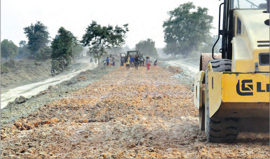
ဥက္ကံသကြားစက်လမ်းပိုင်းနှင့် တဘူးလှဆည်လမ်းပိုင်းတို့ကို ကျောက်ချောလမ်းအဖြစ် ခင်းကျင်းနေစဉ်။
