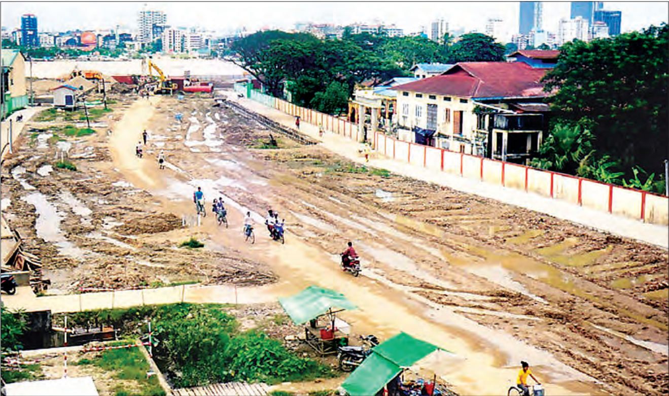
ဒလဘက်အခြမ်း တံတားတည်ဆောက်မည့် ဗိုလ်မင်းရောင်လမ်းမကြီးကို တွေ့ရစဉ်။
