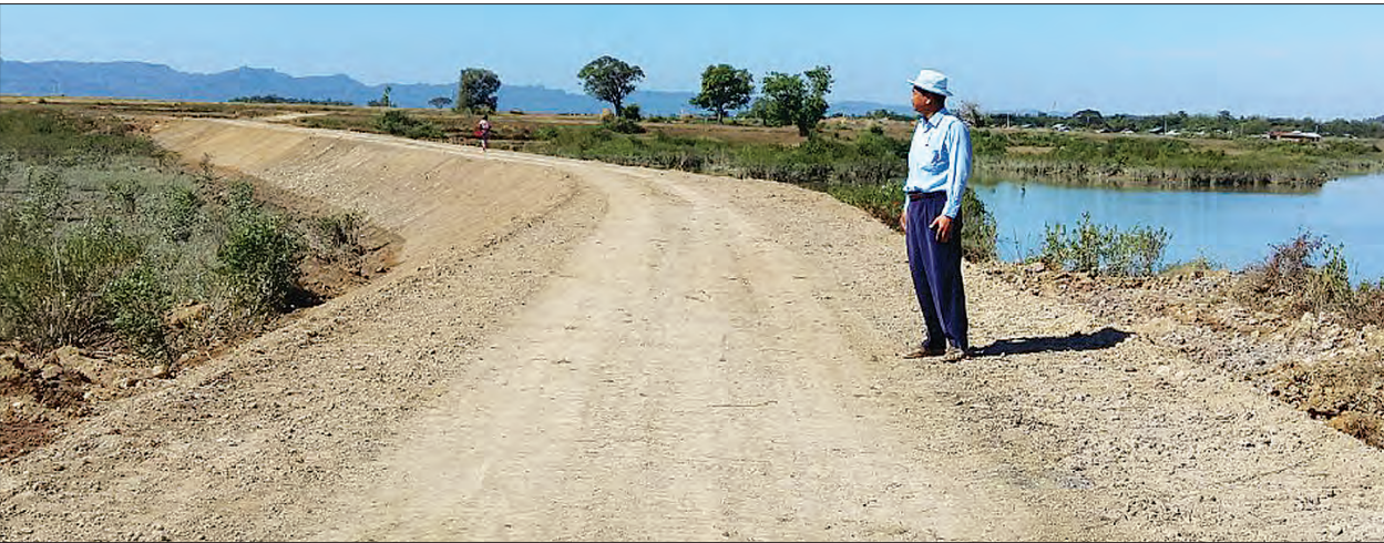
ရသေ့တောင်မြို့နယ်၌ ရေငန်တားတာတမံ တည်ဆောက်ထားမှုကို တွေ့ရစဉ်။
