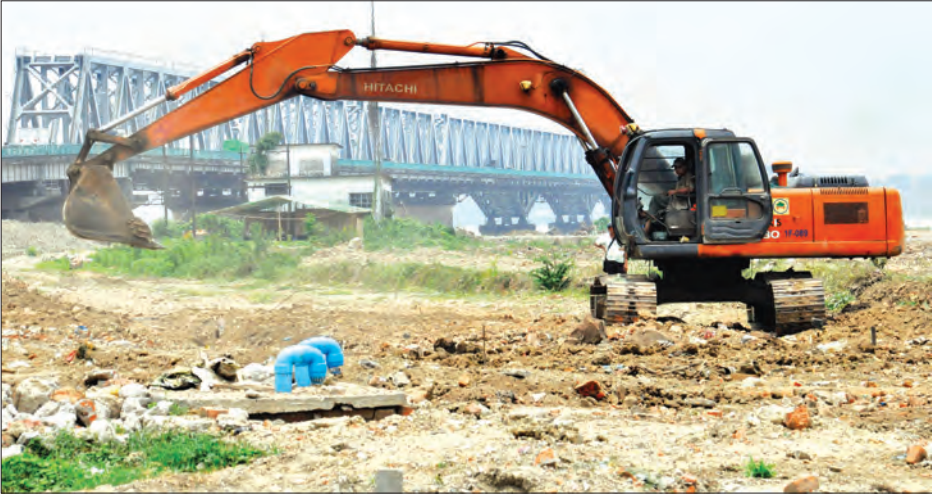
သန်လျင်အမှတ်(၃)တံတားတည်ဆောက်ရန် အကြိုအင်ဂျင်နီယာလုပ်ငန်းများ စတင်ဆောင်ရွက်နေစဉ်။
