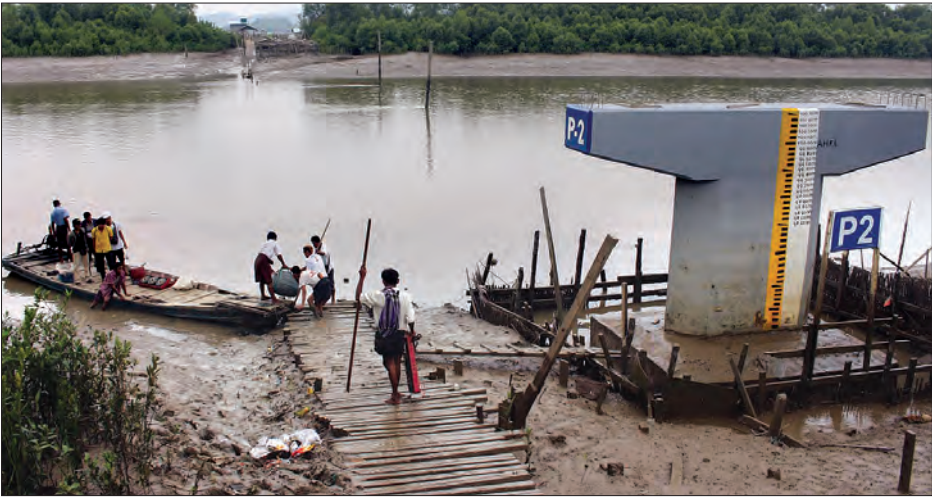
ပရည်တောင်ချောင်းကူးတံတား တည်ဆောက်ရေးလုပ်ငန်းခွင်အား တွေ့ရစဉ်။
