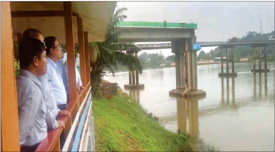
ဒုတိယဝန်ကြီး ဦးကျော်လင်း ပုလုံးတုံးတုံး တံတားတည်ဆောက်ရေးစီမံကိန်း၊ မြိတ်-ကော့သောင်းလမ်းနှင့် ၎င်းလမ်းပေါ်ရှိ တံတားများအား ကြည့်ရှုစစ်ဆေးစဉ်။
