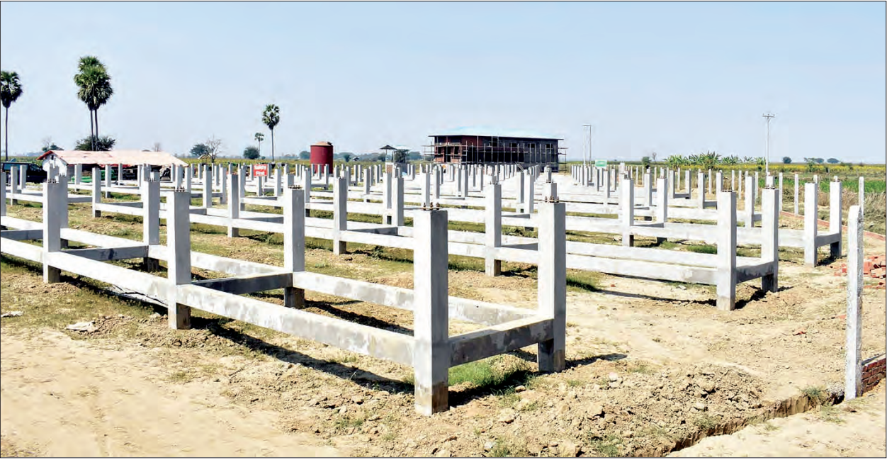
ဆိုလာအသေးစား ဓာတ်အားပေးစနစ်လုပ်ငန်းအတွက် ကနဦးလုပ်ငန်းများဆောင်ရွက်ထားမှုကို တွေ့ရစဉ်။
