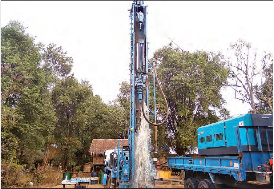
တောင်တွင်းကြီးမြို့နယ် ထောက်ကြံ့တွင်းကျေးရွာ စက်ရေတွင်းရေမှတ်ခြင်းလုပ်ငန်း ဆောင်ရွက်နေသည်ကို တွေ့ရစဉ်။
