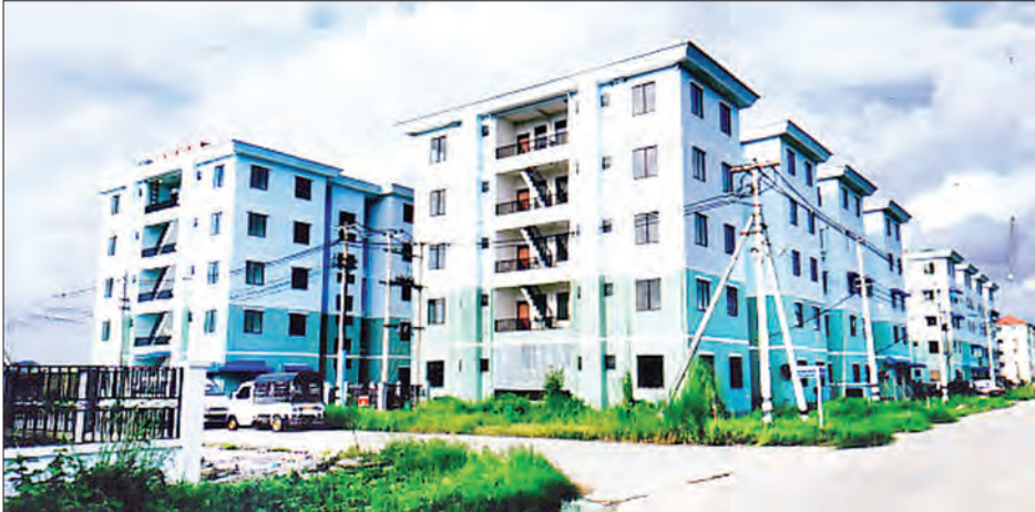
လှိုင်သာယာမြို့နယ် ကျန်စစ်မင်းအိမ်ရာ(အပေါ်ပုံ)နှင့် ကျန်စစ်သားလမ်းမပေါ်မှ အရောင်းဆိုင်များ(ယာပုံ)ကို တွေ့ရစဉ်။
