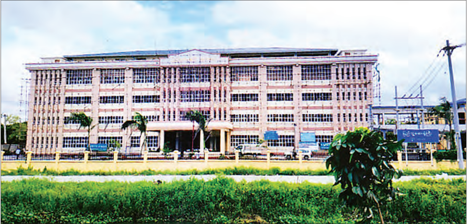
တည်ဆောက်ဆဲ လှိုင်သာယာပြည်သူ့ဆေးရုံသစ်ကြီး
