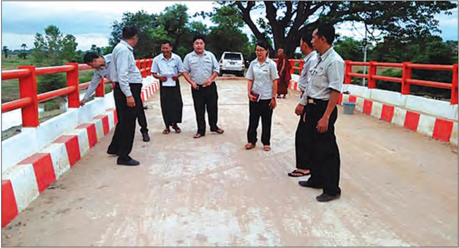
သံကူကွန်ကရစ်တံတားတည်ဆောက်ပြီးစီးမှုကို တာဝန်ရှိသူများ စစ်ဆေးစဉ်။
