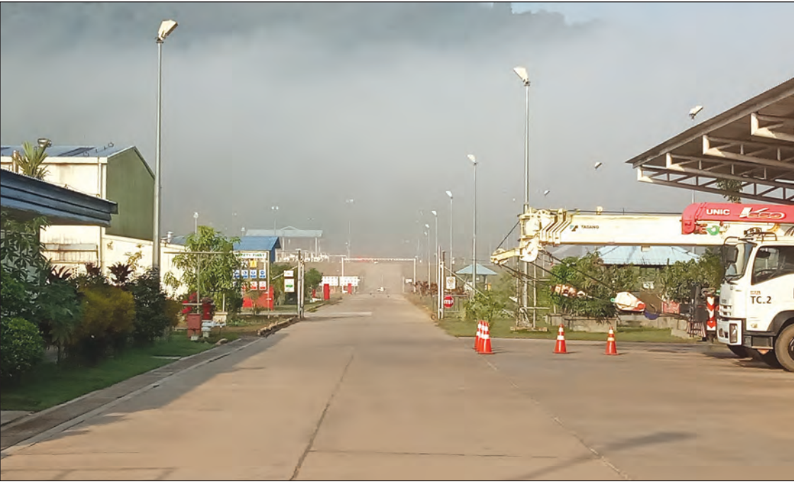
ကန်ပေါက်ကျေးရွာရှိ ဇောတိကစီမံကိန်း၏ သဘာဝဓာတ်ငွေ့ပို့လွှတ်ရာနေရာကို တွေ့ရစဉ်။
