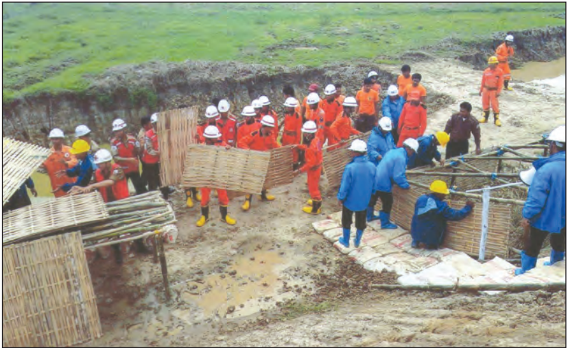
တာကျိုးပေါက်မှုဖြစ်ပါက လိုက်နာဆောင်ရွက်ရမည့်အချက်များကို လက်တွေ့သရုပ်ပြနေစဉ်
