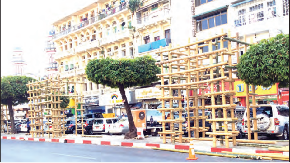
ဆူးလေဘုရားလမ်း၌ ဝါးအလှဆင် စင်မြင့်များ တည်ဆောက်နေစဉ်
