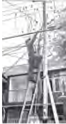
လျှပ်စစ်ဝန်ထမ်းများက ဆောင်ရွက်လျက်ရှိကြောင်း သိရသည်။ (အပေါ်ပုံ) (၇၄၇)
