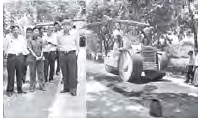
ဆောက်လုပ်နေဝန်ကြီးဌာန ပြည်ထောင်စုဝန်ကြီး ဦးခင်မောင်မြင့် ရန်ကုန်-ပြည်လမ်း ခိုင်တိုင်အမှတ်(၉၃/၄)နှင့် (၉၃/၅)ကြား ကတ္တရာကွန်ကရစ် ထပ်ပိုးလွှာတင်ခြင်းလုပ်ငန်းများ ဆောင်ရွက်နေမှုကို ကြည့်ရှုစစ်ဆေးစဉ်။ (သတင်းစဉ်)
