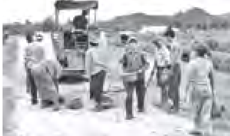
ဩဂုတ် ၁ ရက်က ရှမ်းပြည်နယ်(မြောက်ပိုင်း) ကွတ်ခိုင်မြို့နယ် စည်ပင်သာယာရေးအဖွဲ့သည် မြို့နယ်အတွင်း လွယ်ကူစွာ သွားလာနိုင်ရေးအတွက် မုံရွာမြို့နယ်မှ ရေလုပ်ငန်းများကို ဆောင်ရွက်လျက်ရှိရာတွင် တာလိုင်ကျေးလက်လမ်း ကျောက်ချောင်းခြင်းလုပ်ငန်းကို ဤသို့ ဆောင်ရွက်လျက်ရှိသည်ကို တွေ့ရစဉ်။ (ကြေးမုံ)
