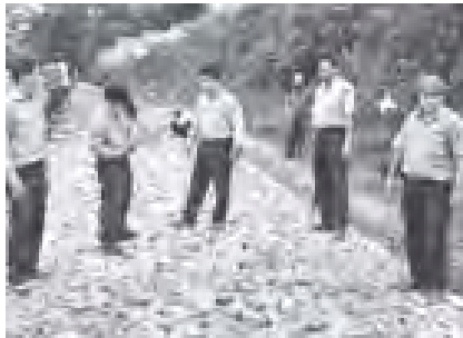
ပန်ဆိုင်(ကြွက်တို)မြို့နယ် စည်ပင်သာယာရေးအဖွဲ့က ဆောင်ရွက် လျက်ရှိသော တောင်ပတ်လမ်း ကျောက်အေးခြင်းလုပ်ငန်းကို ရှမ်းပြည်နယ် (မြောက်ပိုင်း) စည်ပင်သာယာရေးအဖွဲ့မှ အင်ဂျင်နီယာမှူး ဦးမျိုးမင်းသိန်း၊ အမှုဆောင်အရာရှိ ဦးဝင်းမြင့်နှင့် တာဝန်ခံအင်ဂျင်နီယာ ဦးညွှန်ရွှေတို့ တွင်းဆင်းစစ်ဆေးစဉ်။ (မြို့နယ်စည်ပင်)
