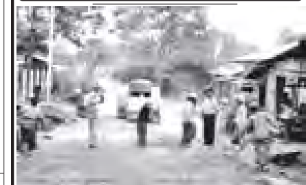
ပြည်မြို့လွင်မြို့နယ် စည်ပင်သာယာရေးအဖွဲ့က ဦးလှဝင်း ကရွှေရာလမ်း ခင်းခြင်း ဆောင်ရွက်နေမှုကို အင်ဂျင်နီယာမှူး ဦးသန်းတိုက်ဦး ကြီးကြပ်ဆောင်ရွက်စဉ်။ (မြို့နယ်စည်ပင်)
