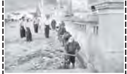
ပေါင်းတည်မြို့နယ် စည်ပင်သာယာရေးအဖွဲ့၊ ဝန်ထမ်းများ စုပေါင်း၍ ရေစိုရေလျှောကောင်းမွန်စေရေးအတွက် ဘုရားကြီးလမ်း ရေမြောင်းကူးဖော် ဆောင်ရွက်နေမှုကို အမှုဆောင်အရာရှိ ဦးတင်ကိုကိုနှင့် တာဝန်ခံအင်ဂျင်နီယာ ဦးအေးမင်းတို့ ကွင်းဆင်းဆောင်ရွက်စဉ်။ (မြို့နယ်စည်ပင်)
